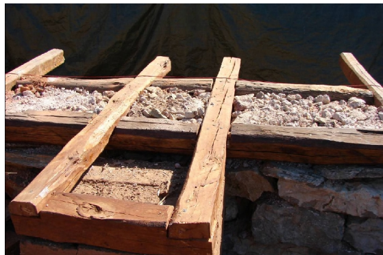
Скрити дървени пояси (къщата на х. Иванчоолу от 1854 в Пловдив разрушена)
